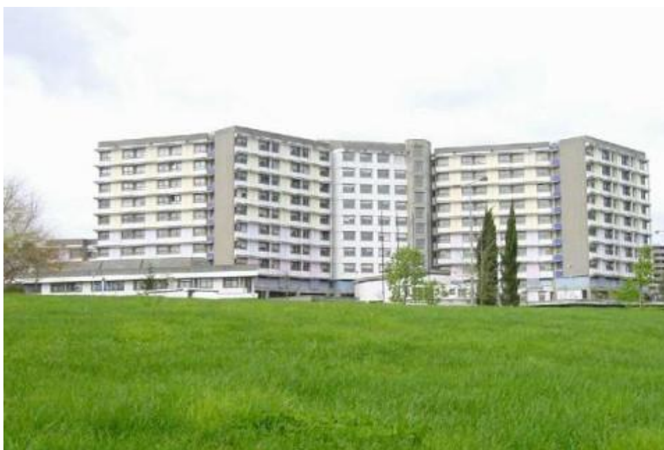
Figura 1 – Centro Hospitalar do Alto Ave, E.P.E. – Unidade de Guimarães (Imagem retirada de CHAA, 2013)
