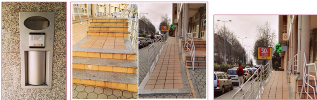
Fig.4- Postigo de atendimento; Escadas/Rampa de acesso e estacionamento.
