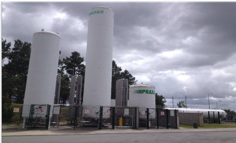
Figura 24. Tanque de Armazenamento dos Gases Medicinais
