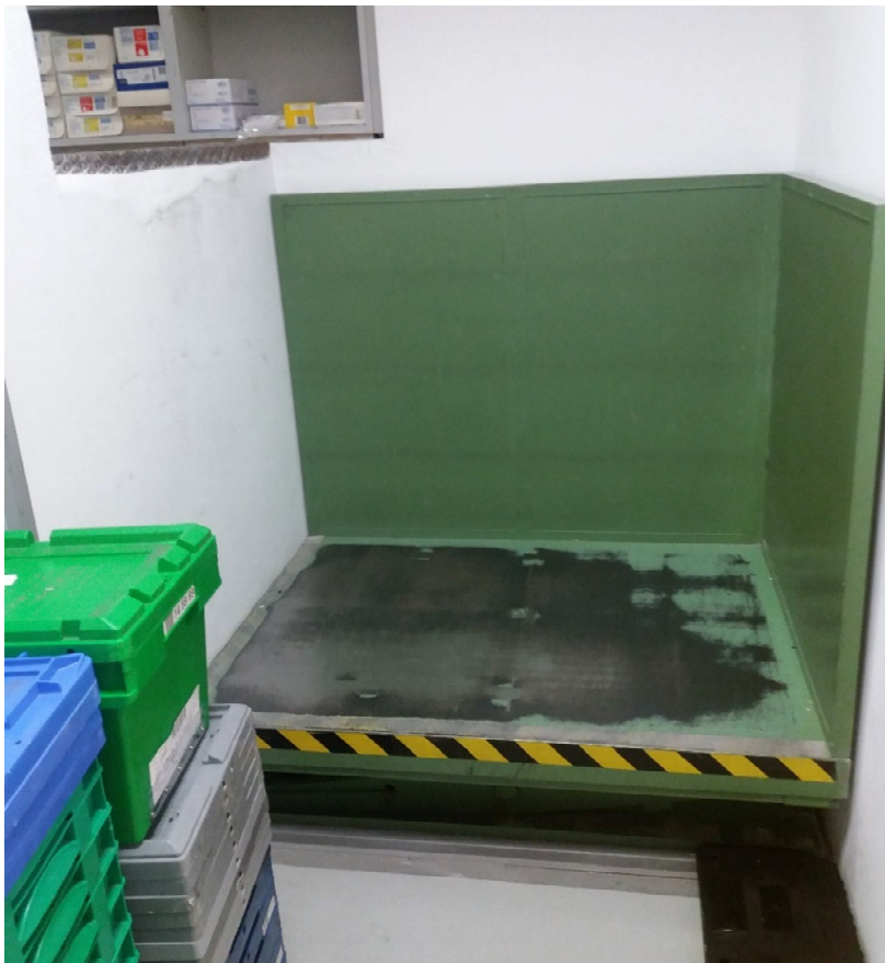
Imagem 4. Plataforma elevatória
