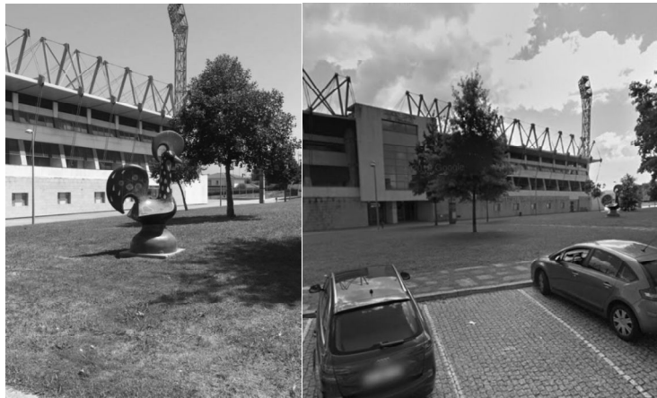
Figura 15 – Estádio Cidade de Barcelos
