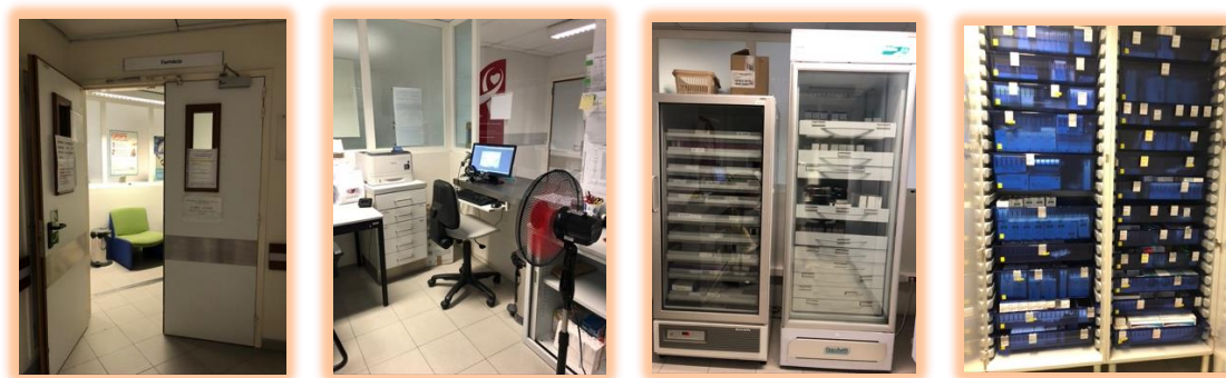
Figura 46: Ambulatório (entrada, sala de ambulatório, frigoríficos, armazém respetivamente)
