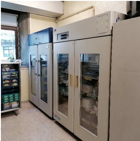
Figura 6 – Armazenamento dos medicamentos que necessitam de refrigeração
