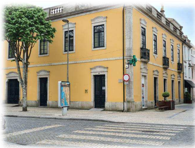
Figura 1: Fachada da FM
