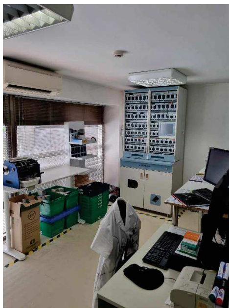
Figura 20 - Sala de Preparação Individualizada da Medicação
