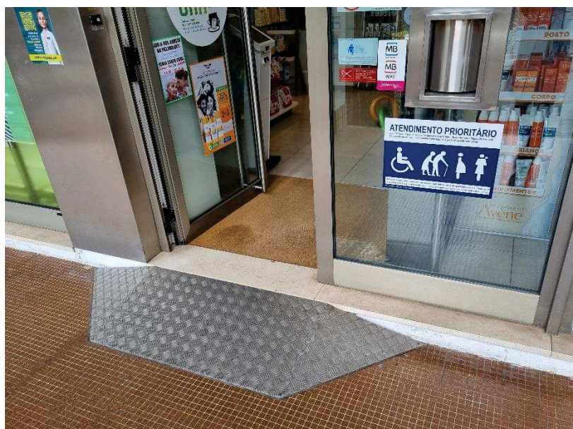
Figura 4 - Rampa de acesso
