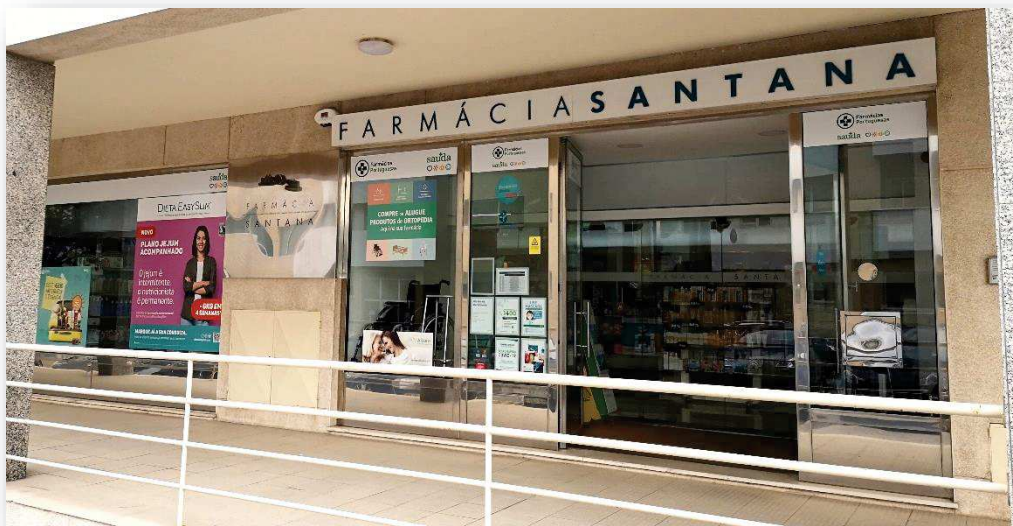
Figura 1. Fachada da Farmácia Santana
