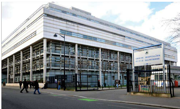
Figura 4: Fotografia do Centro de Cardiologia
