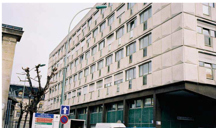
Figura 5: Fotografia do edifício principal do PUI
