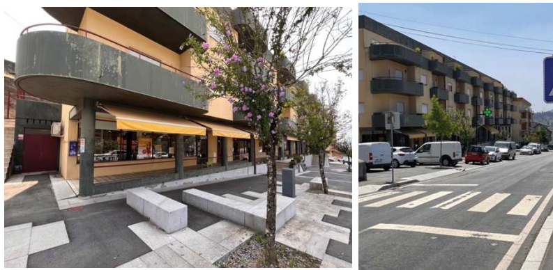
Figura 2: Espaço exterior da FHF, instalada num prédio habitacional.
