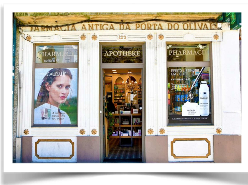
Figura 1: Fachada da FAPO
