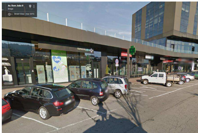
Figura 2: Parte exterior da F.P. [5].
