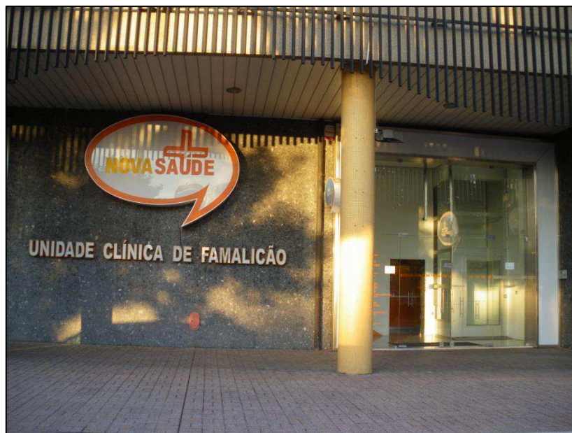
Figura 11 - Fachada da entrada da Unidade Clínica de Famalicão
