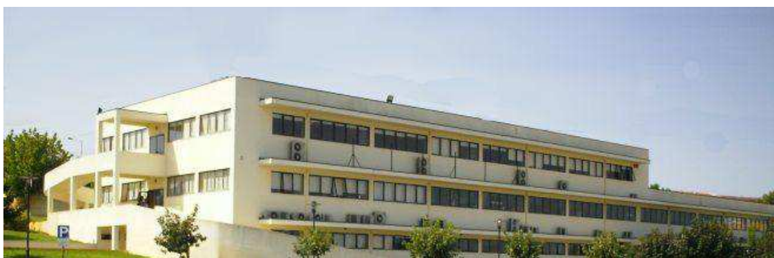
Figura 8 - Escola Superior de Saúde do Vale do Sousa onde se encontra o departamento de Ortopodologia
