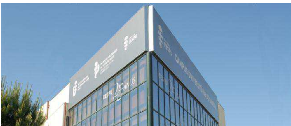
Figura 15 - Instalações da Cespu – Gandra
