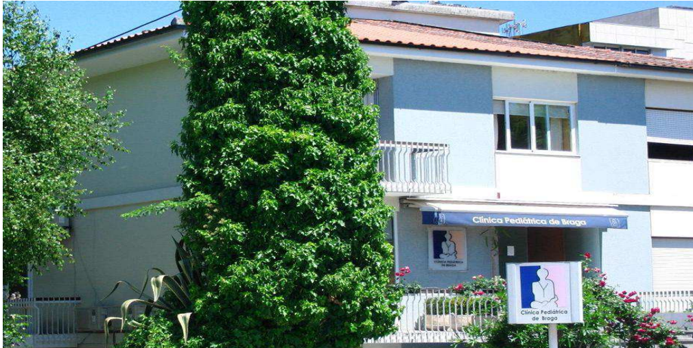
Figura 14 – Clínica Pediátrica de Braga
