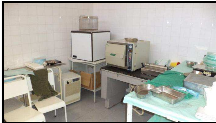
Figura 27 - Sala de Esterilização (Autoclave e mangas)
