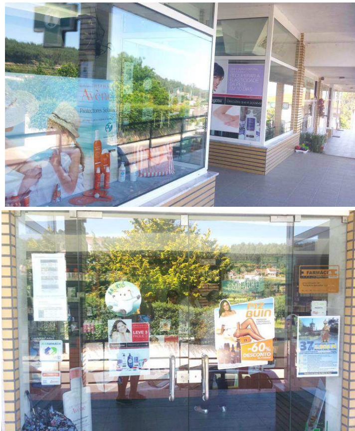
FIGURA 1 - VISTA DE FRENTE DA FARMÁCIA
