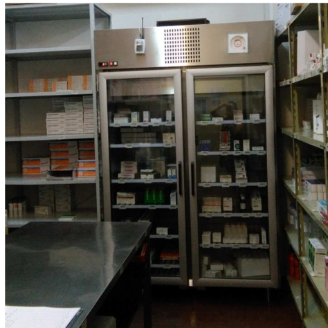
Figura 3 – Frigorífico do armazém principal que armazena a medicação de frio.
