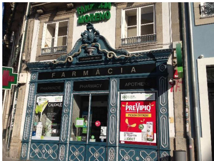
Figura 2 - Fachada da FM
