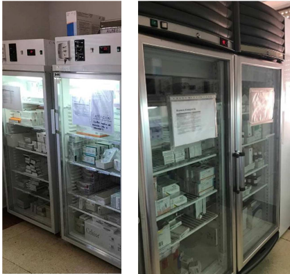
Figura 15. Frigoríficos e congelador para armazenamento de fármacos e preparações do serviço farmacêutico
