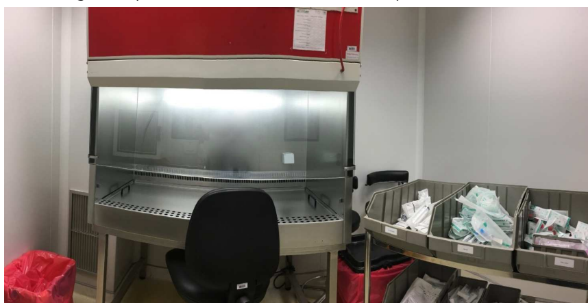
Figura 18: CFLV, utilizada para manuseamento de produtos citotóxicos.
