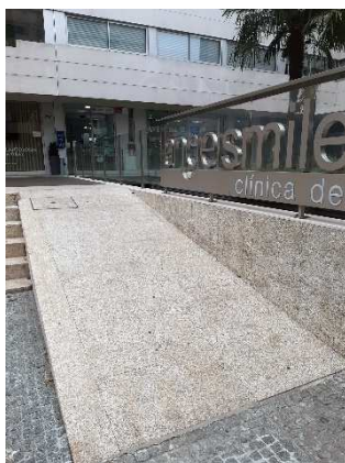
Figura 27- Rampa de acesso à FA
