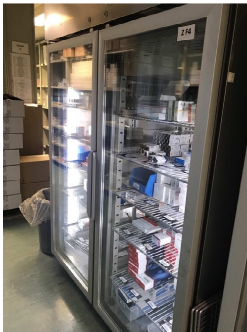
Figura 14. Frigoríficos da zona da distribuição clássica
