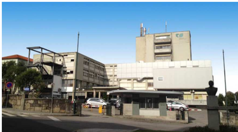
Figura 3. Antigo Hospital distrital
